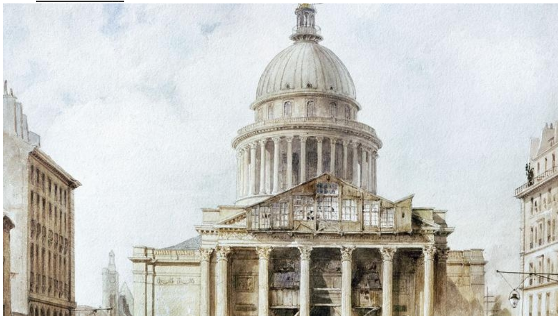
La construction du Panthéon à Paris, vue par le peintre Francois Villeret, en 1835. Crédits photo : Rue des Archives/© Granger NYC/Rue des Archives
